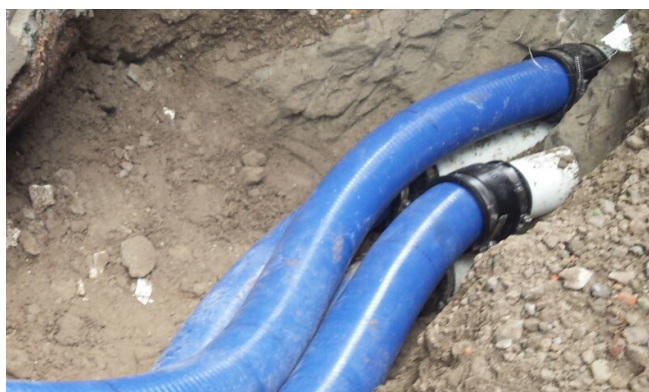
将Hateflex螺旋软管连接到Telstra刚性管路
