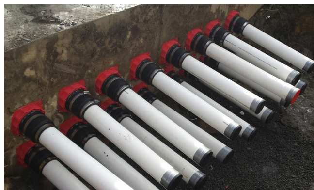
使用KES-M 150-D系统盖 将Telstra刚性管路连接到HSI 150墙面插入件
