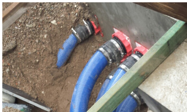
使用KES-M 150-D系统盖连接Hateflex螺旋软管
