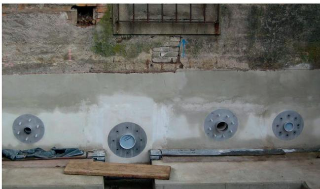
Futterrohre HRD-FUF und HRD-FUFA in den Dimensionen 100, 150 und 200 mm zur Einführung der Ver- und Entsorgungsleitungen.
