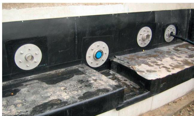
Sockelfundament und gemauerte Kellerwand nach fertiggestellter Flächenabdichtung, angeschlossenen Gebäudeeinführungen nach DIN 18195 Teil 9 vor Verlegung und Einführung der neuen Ver- und Entsorgungsleitungen.
