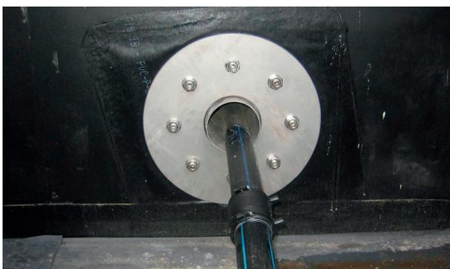
Futterrohr HRD-FUF eingearbeitet in die Bitumenschweißbahn und eingeführtes PE-Rohr DN32 und Schweißmuffe.
