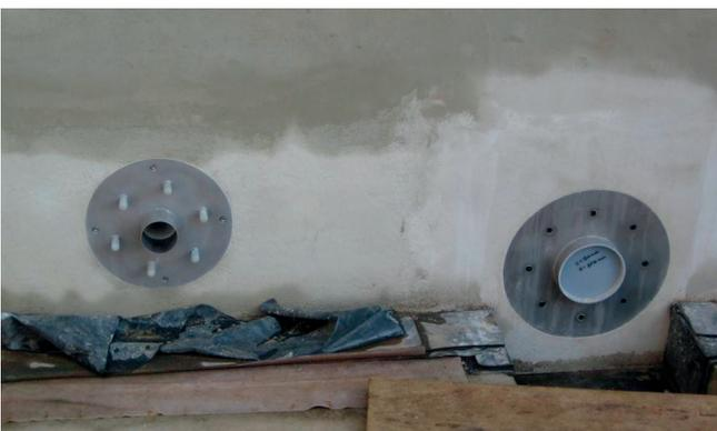
Edelstahl-Futterrohr HRD-FUFA (links zum Andübeln) mit oberflächenbündigem und gereinigtem Klemmbereich.
