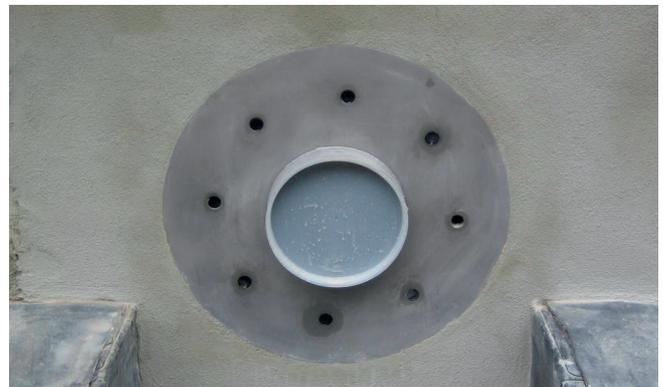
Nach dem Einbetonieren von Futterrohr HRD 200-FUF. Vorbereitet zum flächenbündigen Anschluss der Dichtungsbahn.
