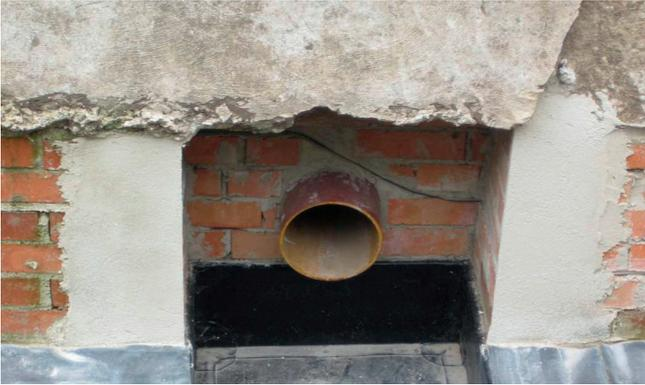
SML-Rohrstützen als Vorbereitung zum Anschluss an das Edelstahl-Futterrohr mit Fest-/Losflansch HRD-FUF.
