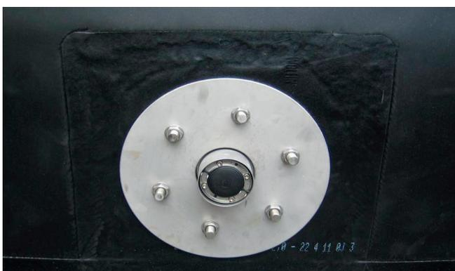
Futterrohr HRD 100-FUF nach Anschluss an die Bitumenbahn inklusive Abdichtung HSD 100-SSG-18-65-SL V2A/EPDM.
