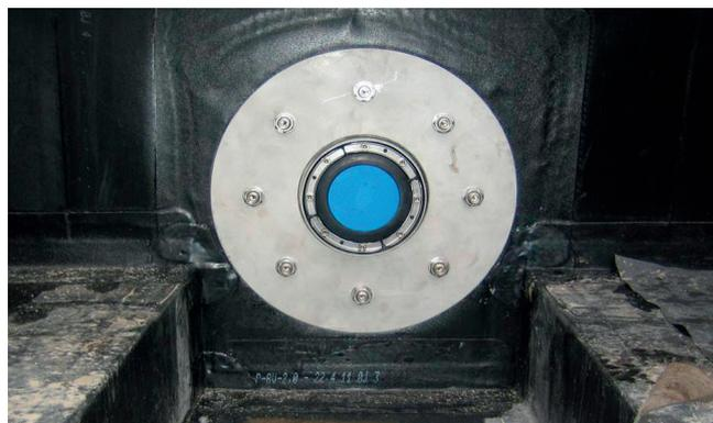
Futterrohr HRD-FUF komplett montiert mit Dichteinsatz HSD 200-SSG-110-160-V2A/EPDM.
