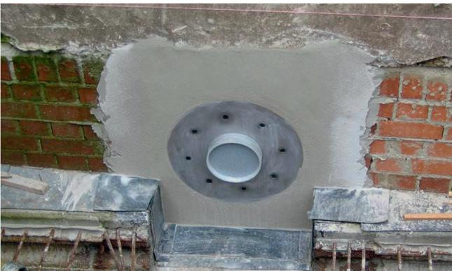
HRD-FUF wurde mit einer Anschlussmanschette auf die richtige Anschlussposition gesetzt bzw. einbetoniert.
