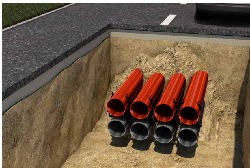
Minimale Verlegetiefe von Kabelschutzschläuchen bei Schwerlastverkehr SLW60
